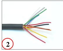
Spread apart wires, untwist pairs if necessary
